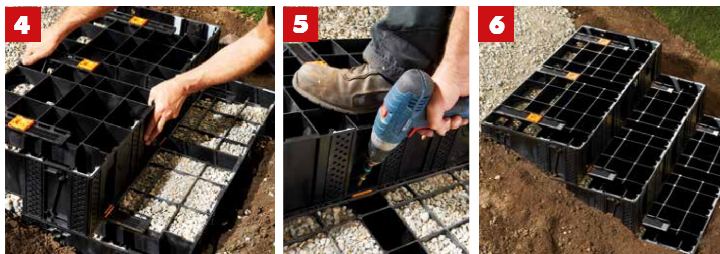
Die erste Stufe ausrichten, 1% Gefälle nach vorne wegen Wasserablauf.
